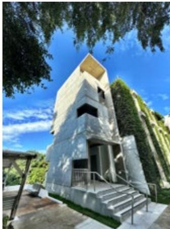
Se realizó la demolición total de la escalera de acceso exterior, la cual se encontraba en estado de deterioro, y reemplazarla por una escalera nueva, y la construcción de una rampa de impedidos en hormigón en cumplimiento con el "International Building Code" y la Ley ADA.
