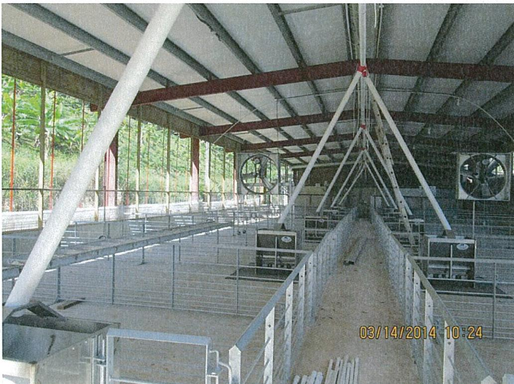
Figure 22 ESTRUCTURA, PISOS, CORRALES, SISTEMA ALIMENTACION Y ABANICOS PARA INDUSTRIA PORCINA- EMPRESAS LA CEBA, INC - COROZAL
